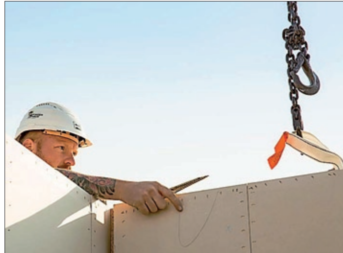
Ein FingerHaus-Monteur bei der Arbeit.
